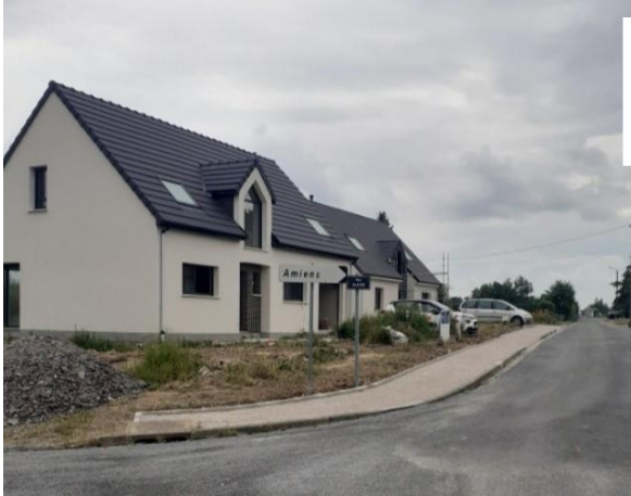
◀ Bordurage rue Alexis au nouveau lotissement
